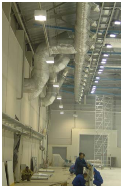
Монтаж системы вентиляции в Ледовом дворце в Мытищах
